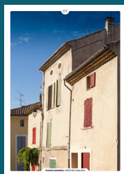
01 les façades enduites
